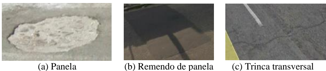
Figura 2: Detecção de defeitos em pavimentos rodoviários pelo Google Earth (Fonte: Ferreira e Castelo Branco, 2016)
