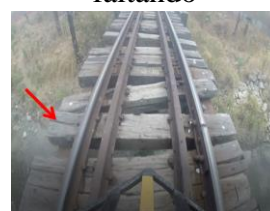
(e) Severidade 4: Dormentes rachados, deslocados e faltando
