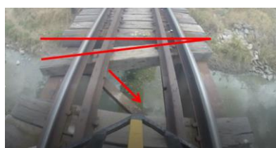
(e) Severidade 4: Dormentes rachados, deslocados e faltando
