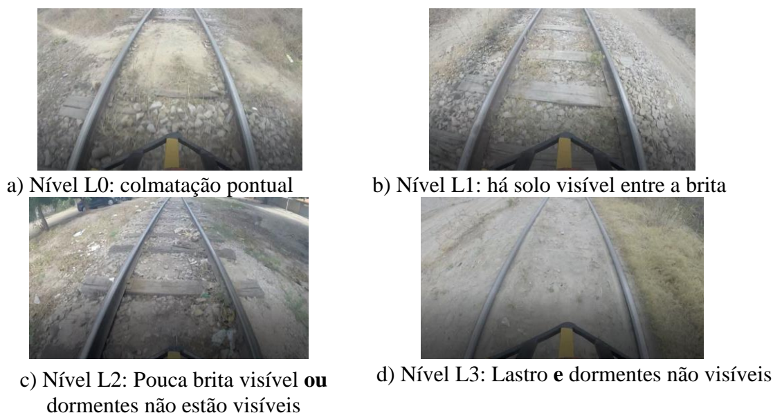
Figura 5: Níveis de severidade sugeridos para o lastro (Fonte: Elaborado pela autora)
