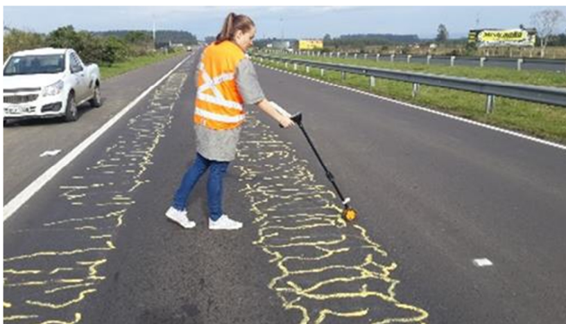
Figura 4: Levantamento da área trincada (Julho de 2017).
