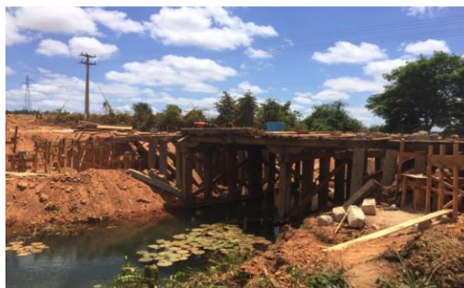
Figura 3 – Ponte de madeira existente sobre o Igarapé Vitória
