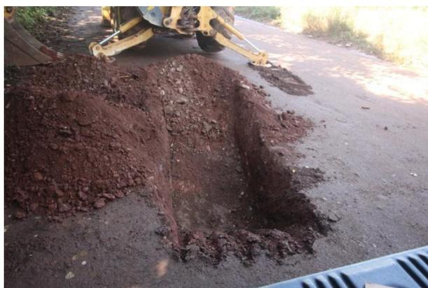
**Figura 2:** Escavação da trincheira para coleta do solo
