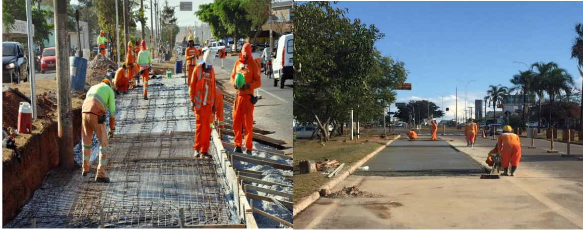
Figura 2- Confecção das placas de CCP. Fonte: Autor 2018.
