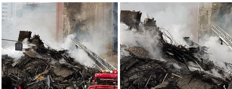
Figura 3: Registro dos escombros gerados no evento. Data: 01 de maio de 2018.
