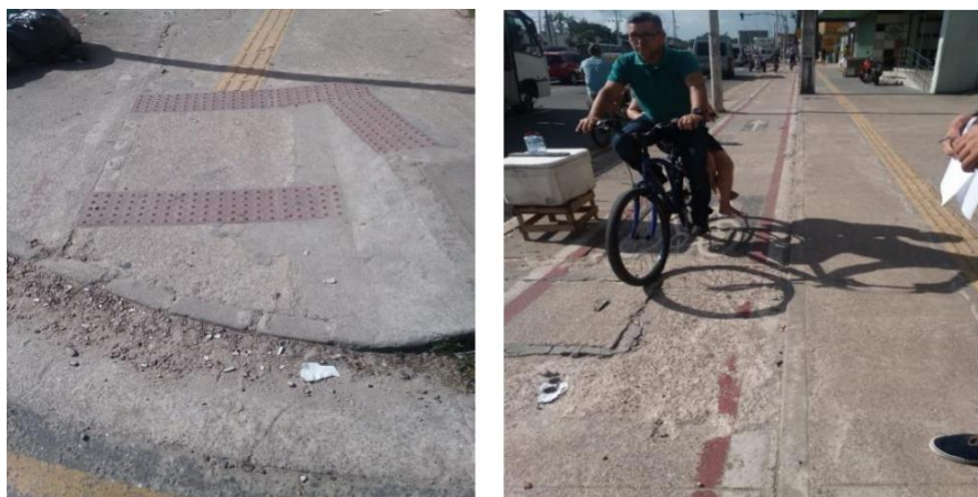
Figura 06 e 07: Condições de acessibilidade na Avenida Augusto Montenegro.
