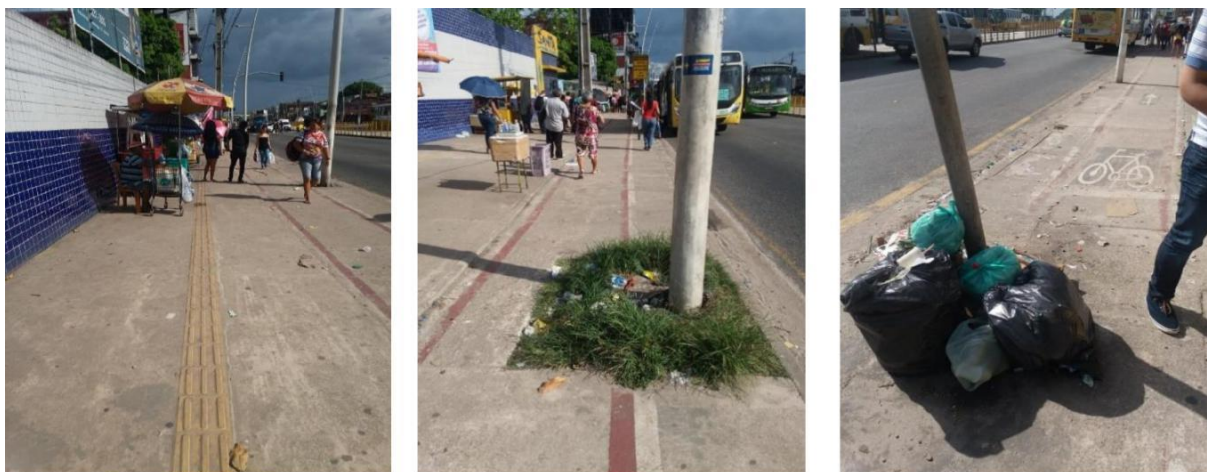
Figuras 08, 09 e 10: Condições das calçadas e ciclovias no trecho 1.
