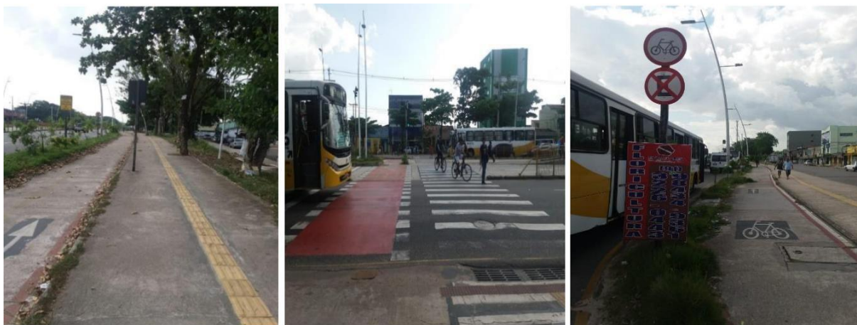
Figuras 14, 15 e 16: Condições das calçadas e ciclovias nos trechos 3 e 4.
