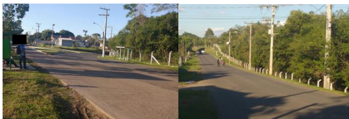
Figura 2: Sinalização inexistente (sentido do Bairro Morretes ao Centro)
