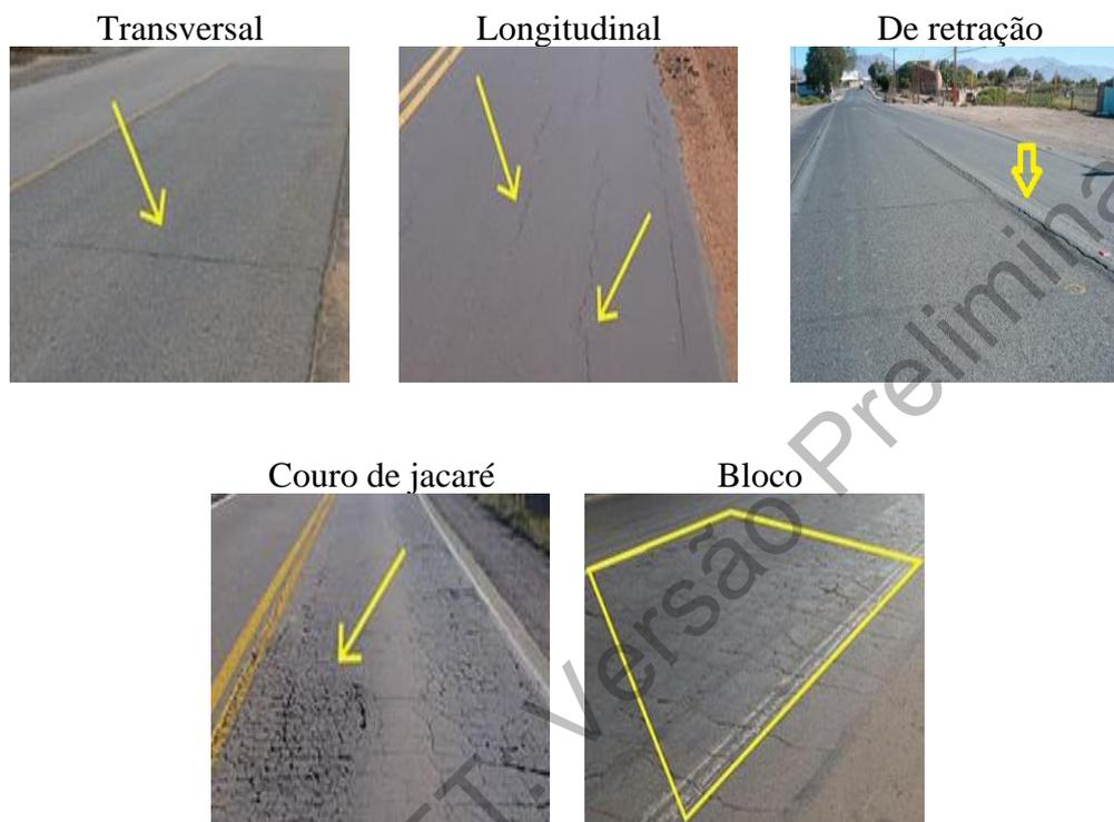
**Figura 1:** Exemplos de trincas
