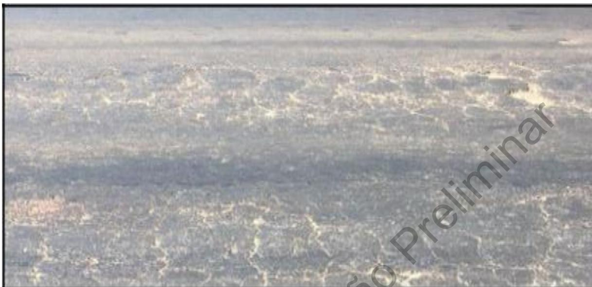
**Figura 4:** Fendas Transversais e Pele de Crocodilo
