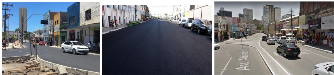
Figura 6: Aspecto da via após execução
