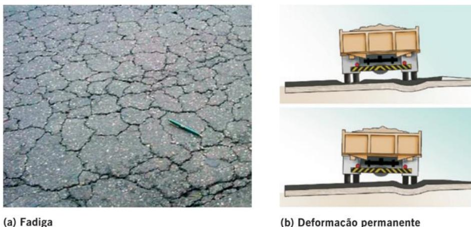
**Figura 1:** Defeitos estruturais de trincamento e afundamento por repetição de cargas
