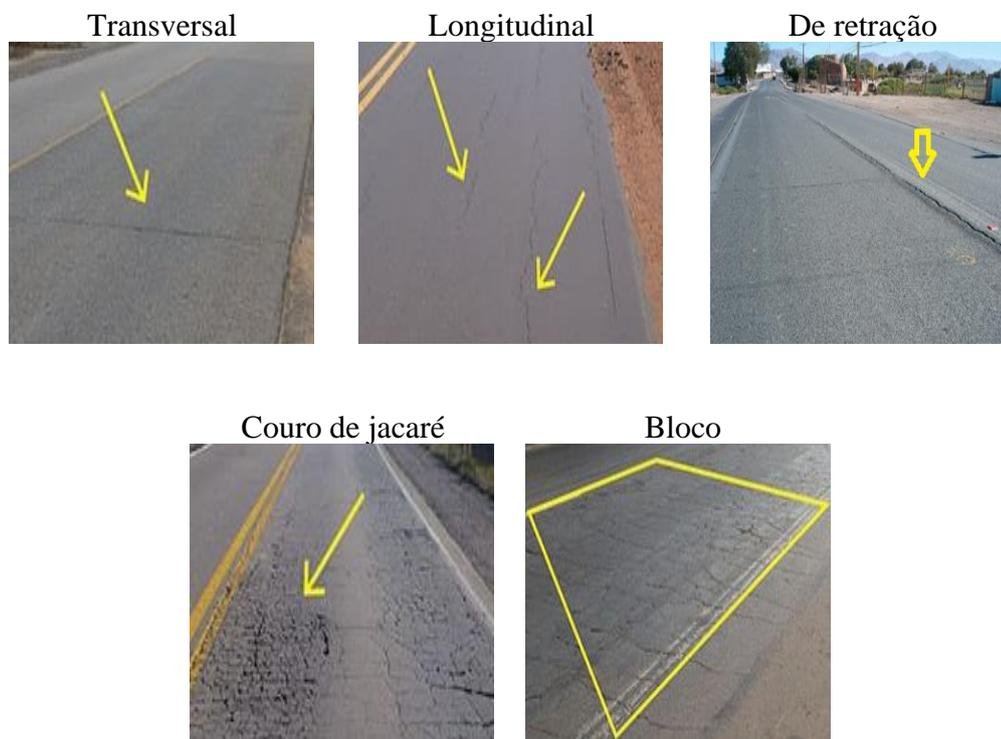
**Figura 1:** Exemplos de trincas
