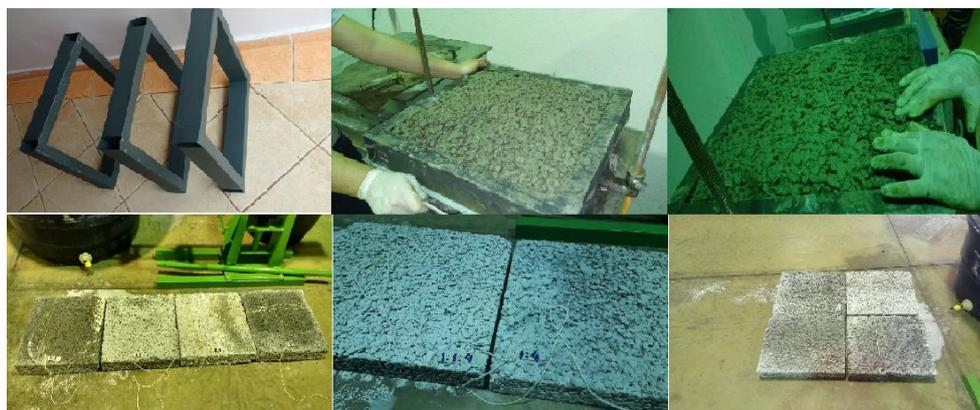
**Figura 4:** Processo de moldagem das placas de concreto.
