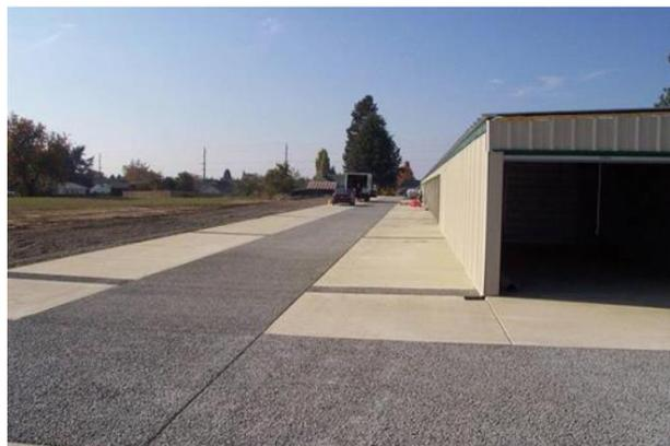
**Figura 2:** Aplicação de concreto drenante em Pavimentação.
