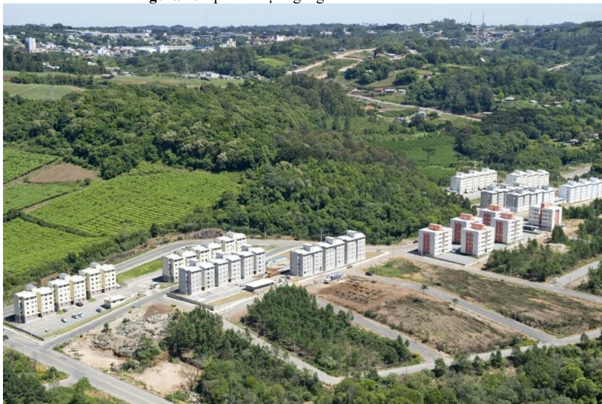
Figura 2: Foto aérea do empreendimento
