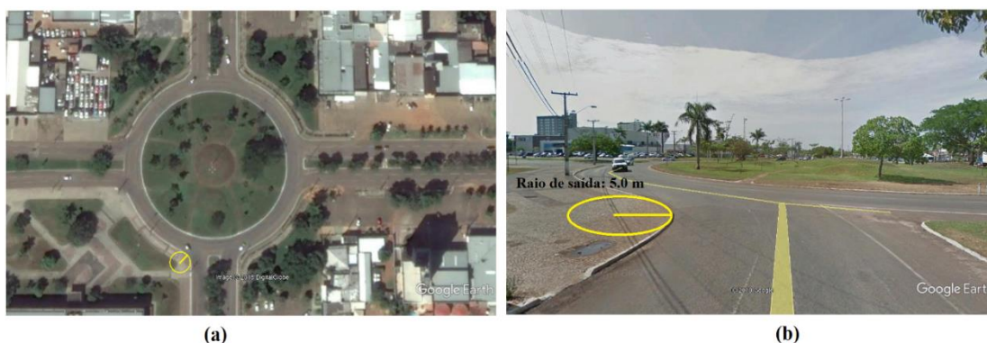
Figura 5: (a) vista superior e frontal (b) da saída de rotatória com raios pequenos. Fonte: Google Earth (2015)
