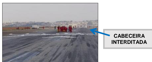
Figura 2: Cabeceira interdita em uma das Pistas do Aeroporto Internacional de Guarulhos.
