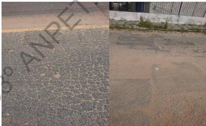
**Figura 4:** Fissuras e reparações
