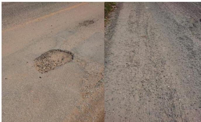
**Figura 5:** Painelas e desgaste
