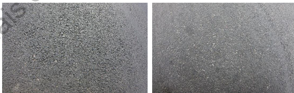
Figura 2: Detalhe da textura do revestimento em CPA dos pontos 9 e 2, respectivamente
