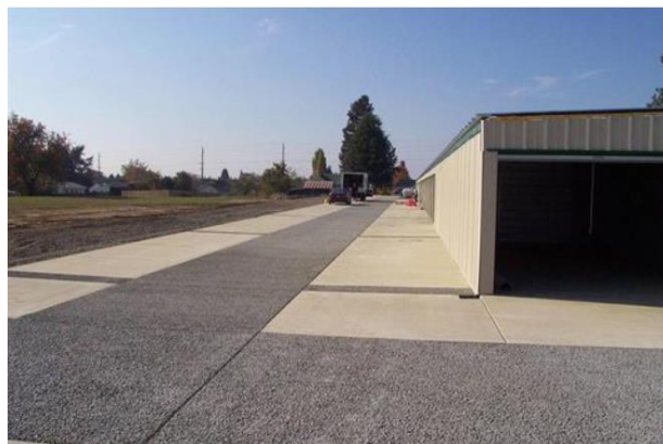
Figura 2: Aplicação de concreto drenante em Pavimentação.
