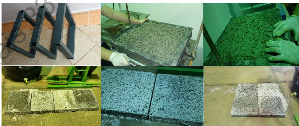
Figura 4: Processo de moldagem das placas de concreto.
