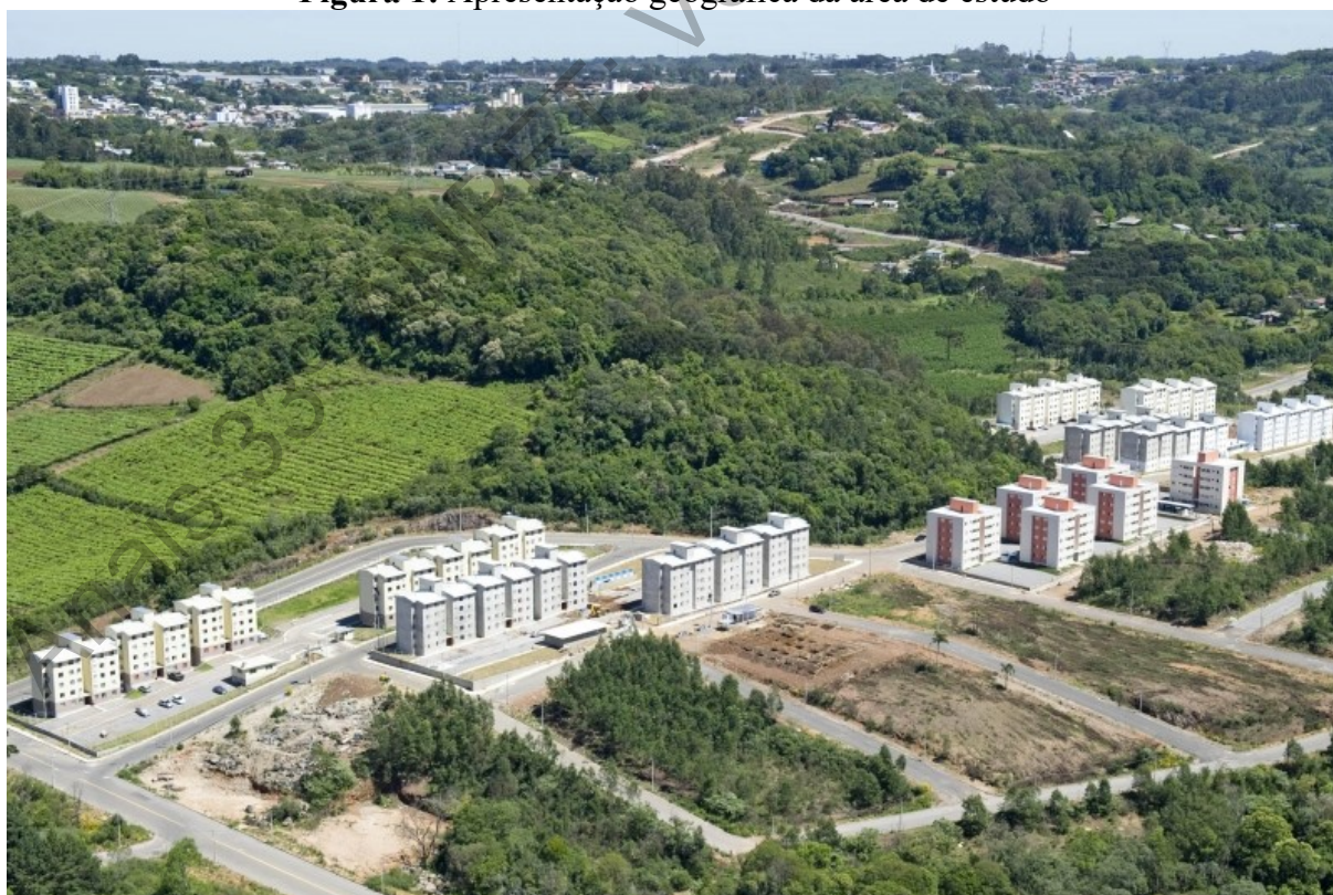
Figura 2: Foto aérea do empreendimento
